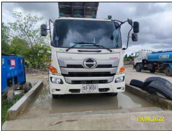
รูปที่ 2-7 การจัดทำพื้นที่ล้างล้อพร้อมทั้งล้างทำความสะอาดเศษดิน และเศษโคลนที่ติดกับล้อรถ ก่อนออกจากพื้นที่เก็บกองท่อ (Stock Yard) และพื้นที่ก่อสร้าง
