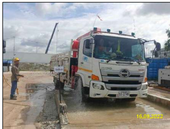
รูปที่ 2-7 การจัดทำพื้นที่ล้างล้อพร้อมทั้งล้างทำความสะอาดเศษดิน และเศษโคลนที่ติดกับล้อรถ ก่อนออกจากพื้นที่เก็บกองท่อ (Stock Yard) และพื้นที่ก่อสร้าง
